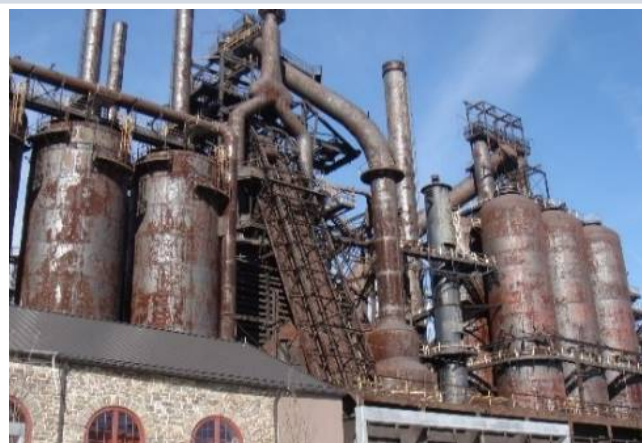
◀鉄鋼メーカーの廃工場
